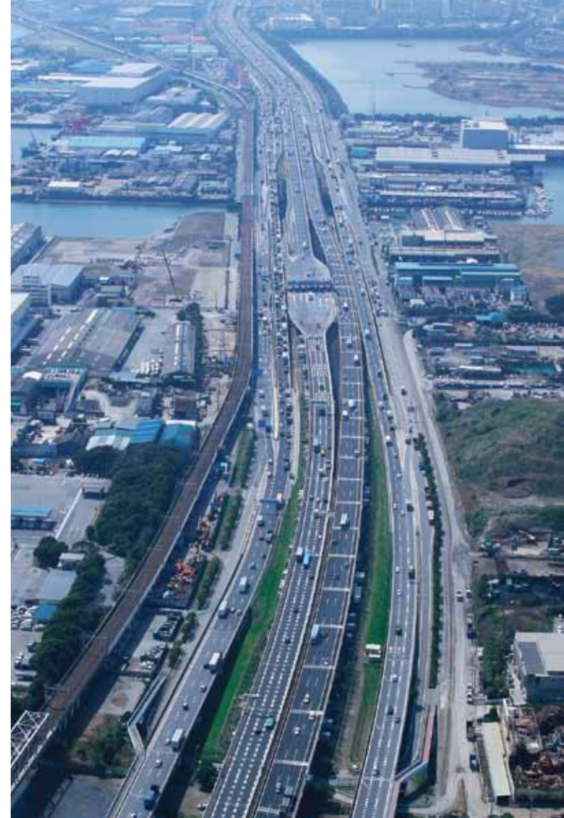
高浜立体付近
