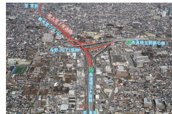
②与野JCT(仮称)付近(平成31年3月撮影)
