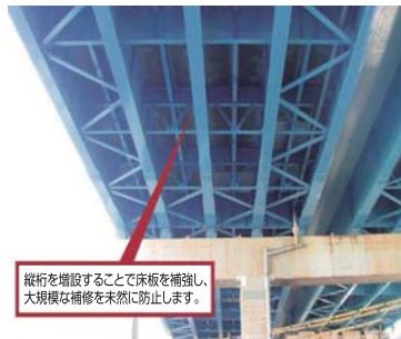
橋梁補修の例
