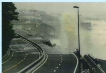
平成19年9月の台風9号による西湘バイパスの被災状況
