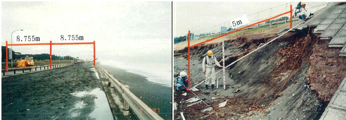
図3.4 道路復旧区間(上:被災状況、左:堆砂状況、右:擁壁被災状況)
