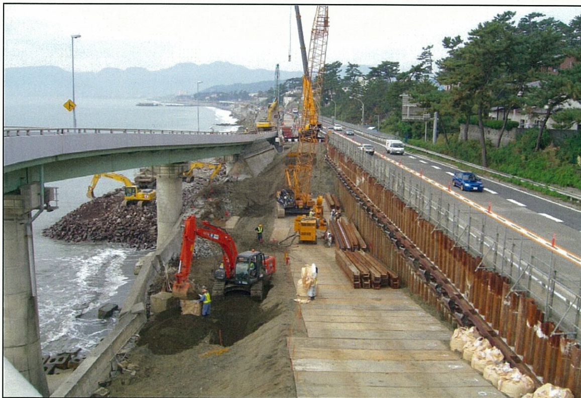
③擁壁取り壊しヤード造成作業状況 （今後シートパイルを打設し負荷軽減後 擁壁取り壊し）
