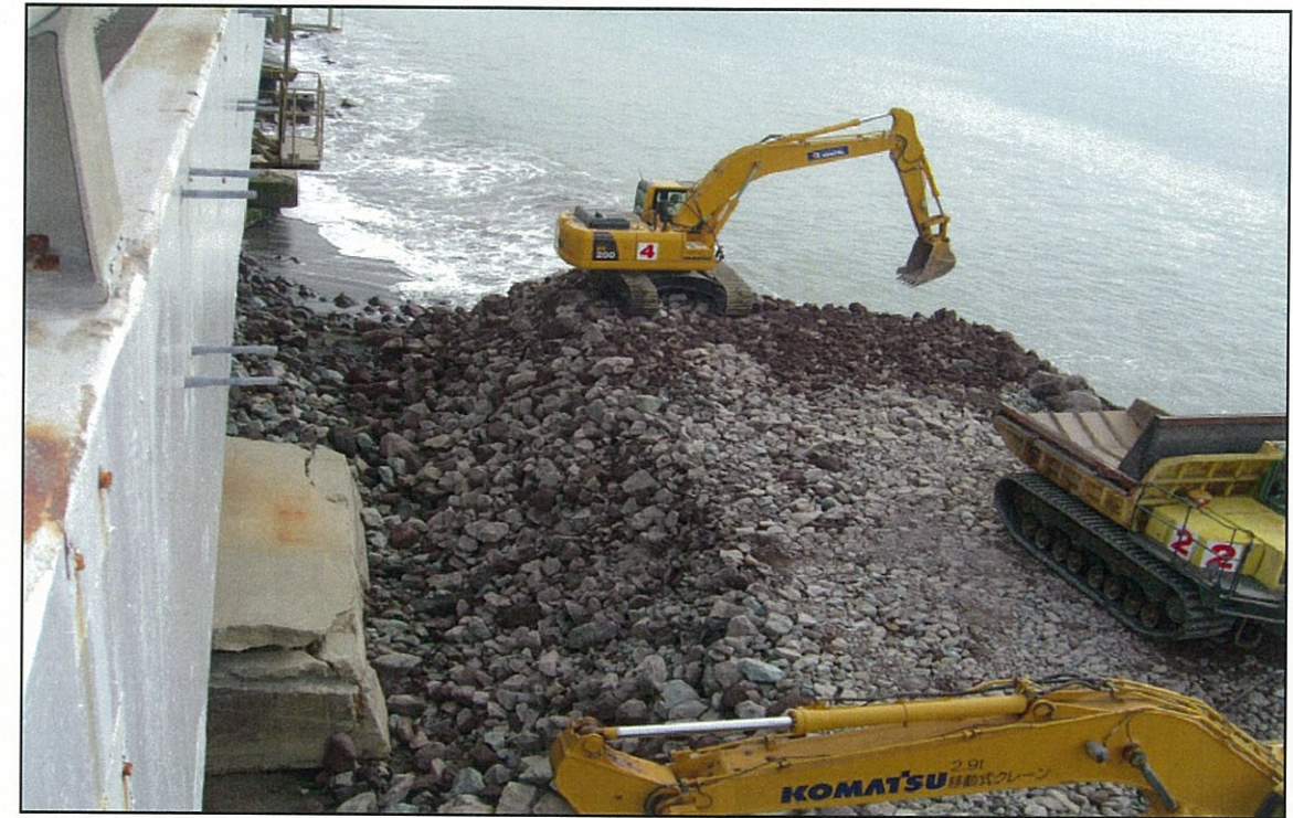
② 銀波橋P3付近 工事用道路設置状況
