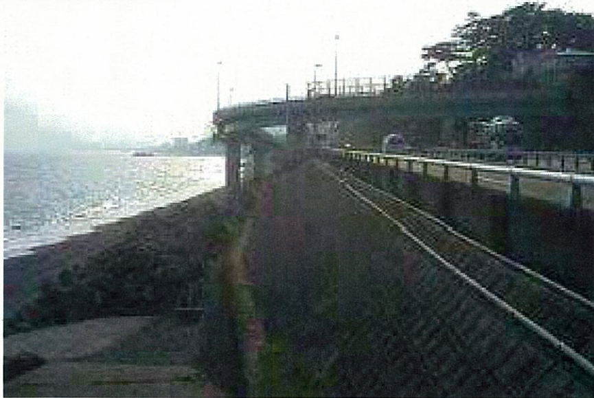
写真①被災前 国交省区間より
