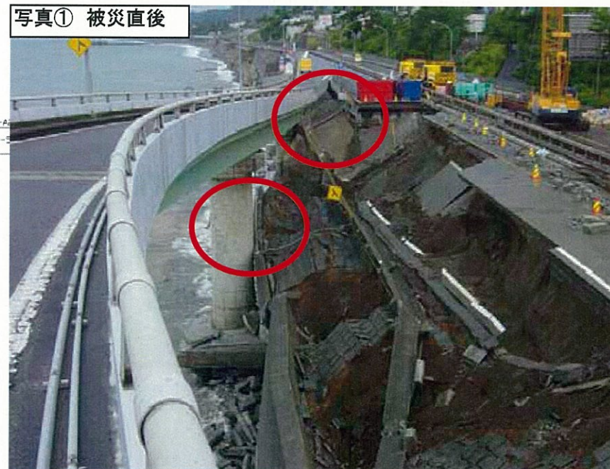
写真④ P4橋脚付近での橋台ウイングの干渉状況
