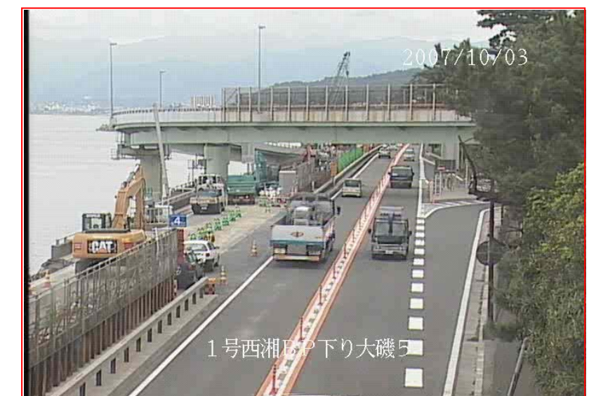
写真1.1 暫定2車線供用後の状況
