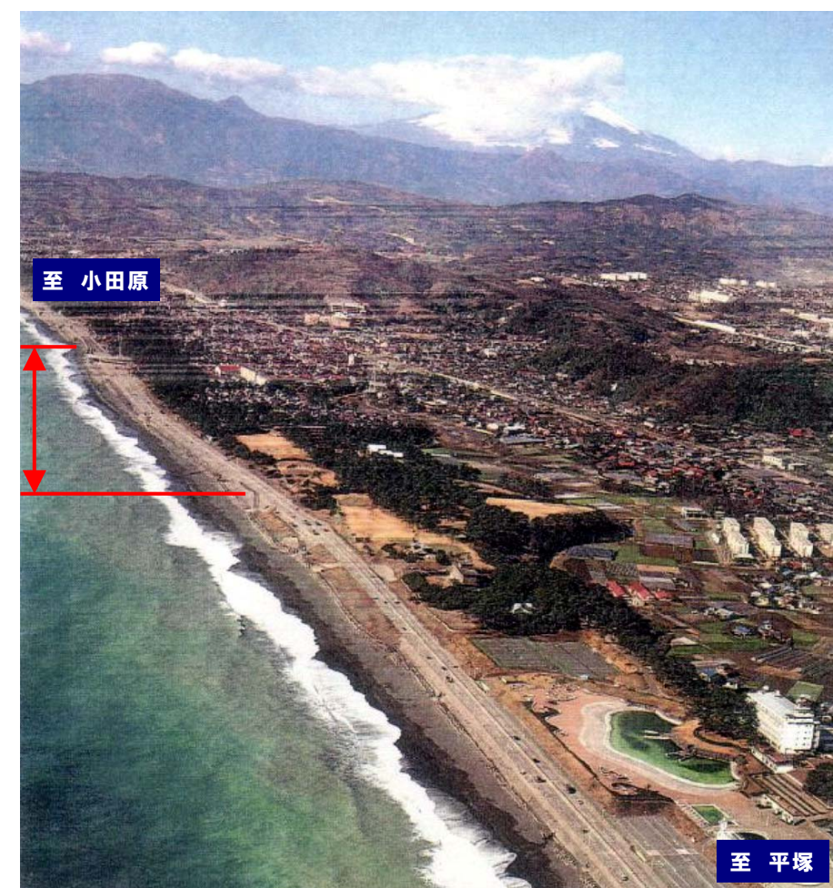
写真2.1 西湘バイパス建設当時の写真（出典：（独）土木研究所）
