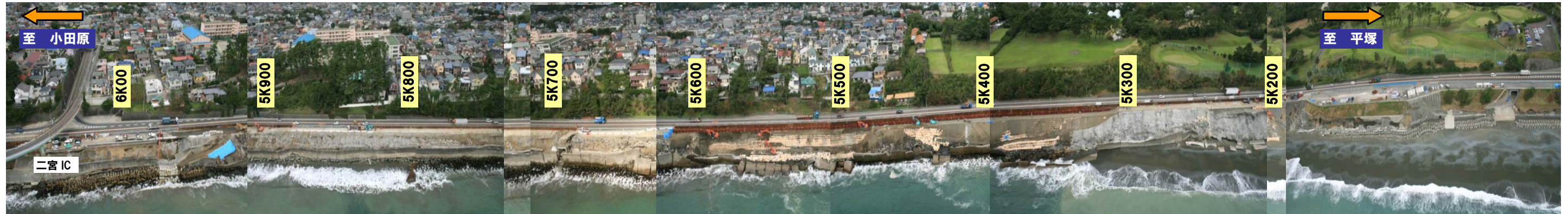
写真 3.1 被災区間工事進捗状況
