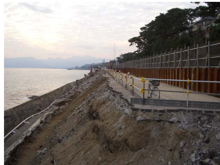
写真 3.3 5K700 起点側～終点側 (平成 19 年 10 月 23 日撮影)
