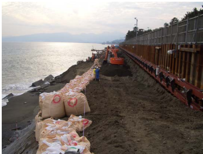
写真 3.2 5K300 起点側～終点側 (平成 19 年 10 月 23 日撮影)
