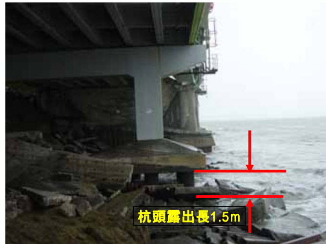
写真 金波橋P1(銀波橋P5)洗屈状況 海側洗屈(杭頭約1.5m) 山側洗屈(杭頭約3m)
