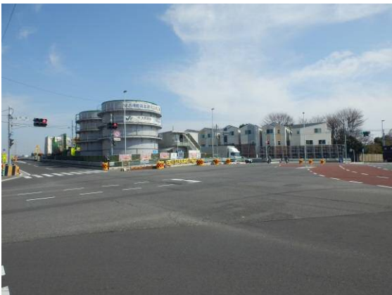
【藤沢立坑工事状況(平成30年4月撮影)】
