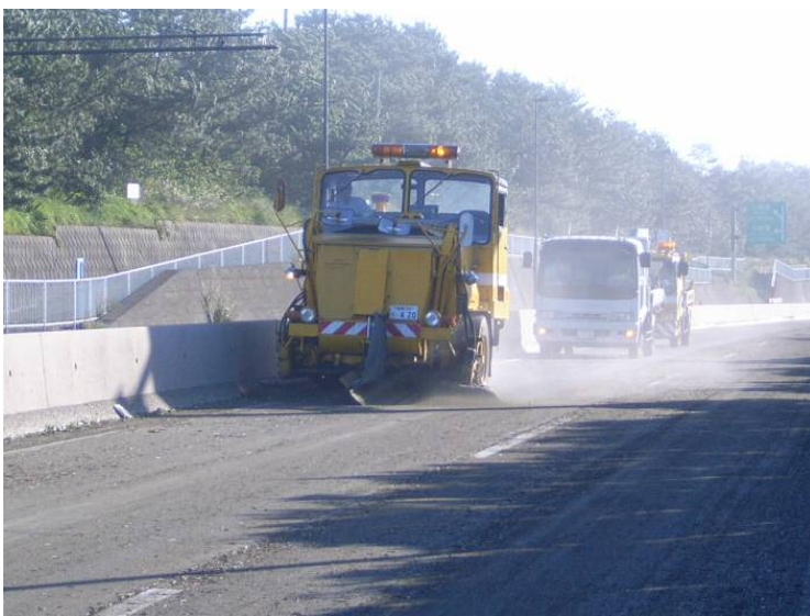
台風後の路面清掃 (国道1号西湘バイパス)
