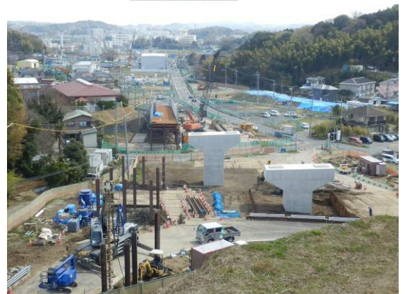
- 5/17 - 【戸塚区小雀高架橋工事状況(平成30年4月撮影)】
