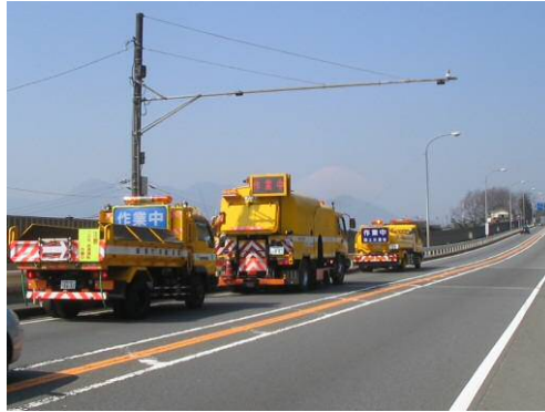
清掃 (路面清掃・排水施設清掃等)
