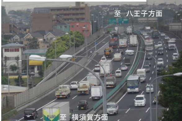
【現況写真(国道16号保土ヶ谷BP)】
