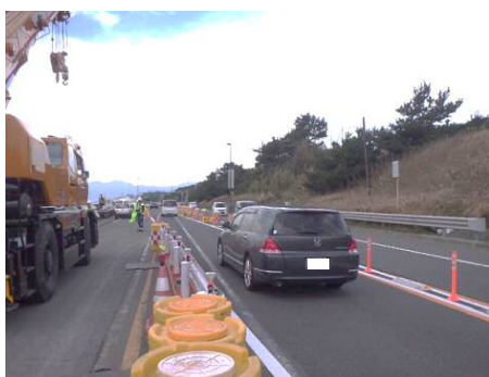
対面通行状況 (平成29年10月25日完了)
