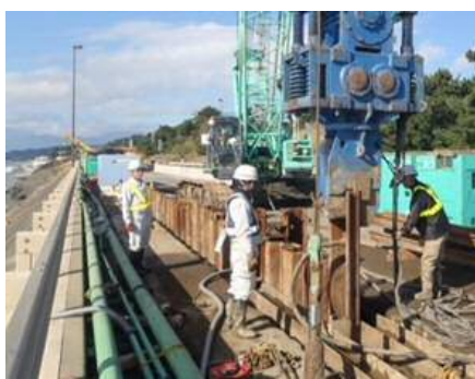
応急復旧 鋼矢板打設1列目状況 (平成29年11月10日完了)
