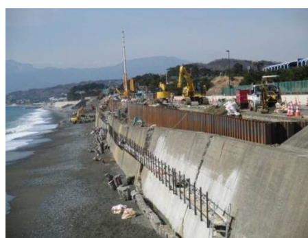
鋼矢板(2枚目)打設状況 (平成30年2月10日完了)
