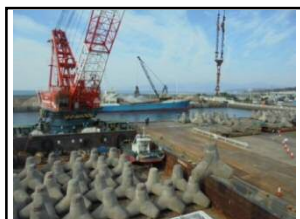
消波ブロックの荷下状況 (大磯港)
