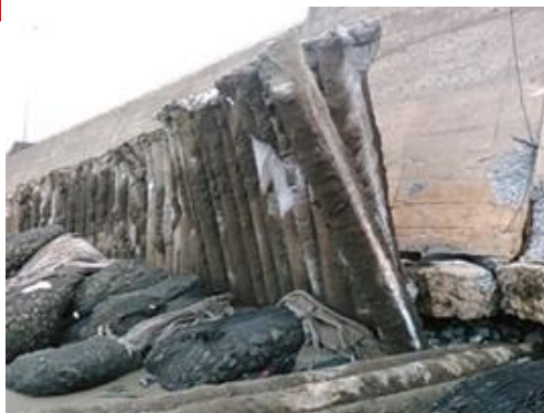
護岸擁壁洗掘状況
