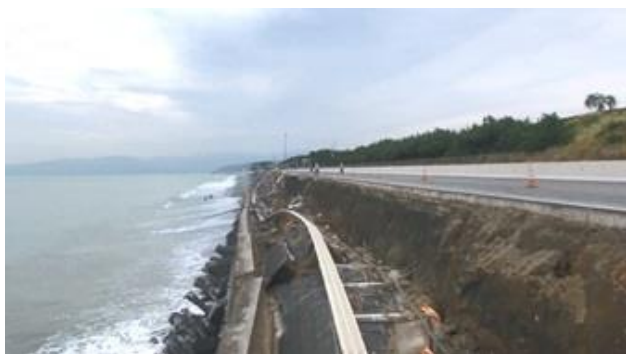
護岸及び道路崩落状況
