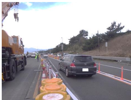
対面通行状況 (平成29年10月25日完了)
