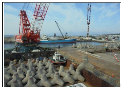
消波ブロックの荷下状況 (大磯港)
