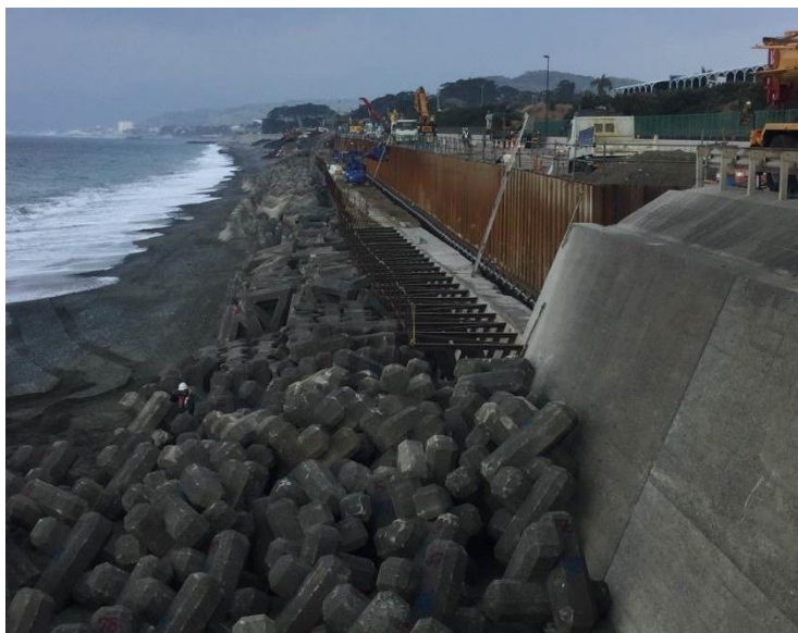
消波ブロック設置完了 (平成30年4月11日)
