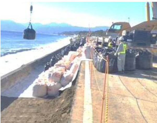
応急復旧 大型土嚢設置状況 (平成29年12月25日完了)
