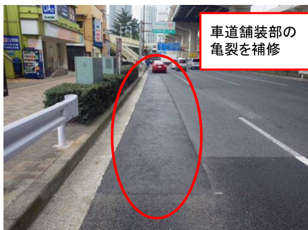
点検結果(補修後)
