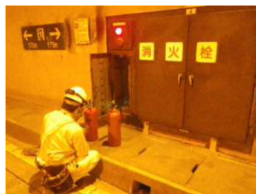
▲設備点検の状況(H28.6)
