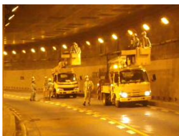
▲照明点検の状況(H28.6)
