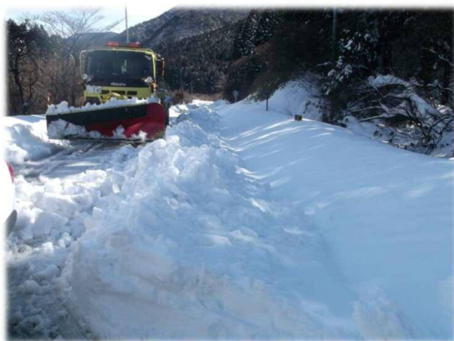
箱根新道での除雪作業
