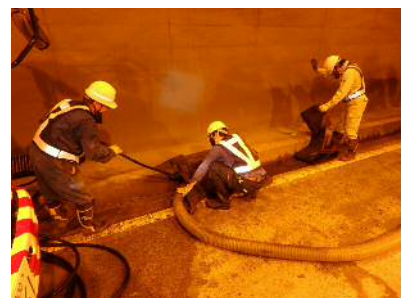
▲排水施設清掃の状況
