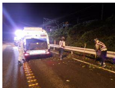
▲樹木伐採の状況
