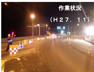
▲通行規制の状況
