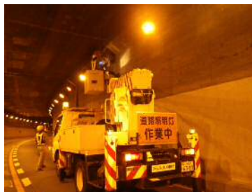
▲照明点検の状況(H27.12)
