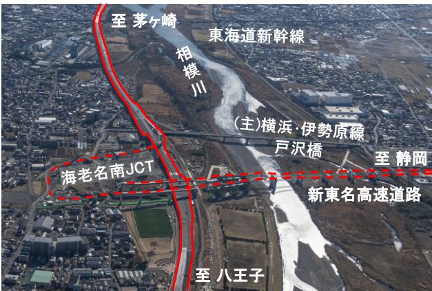
えびなし かどさわばし ②海老名南JCT(海老名市門沢橋) 平成28年度開通予定
