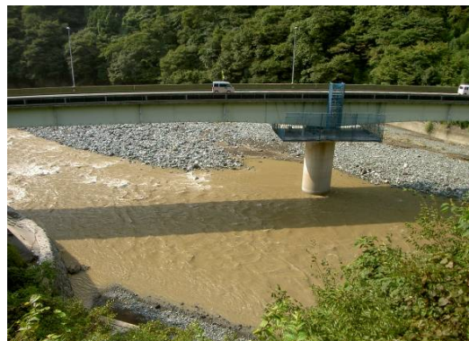
落橋防止装置設置工
