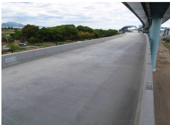
完成又は施工状況写真
