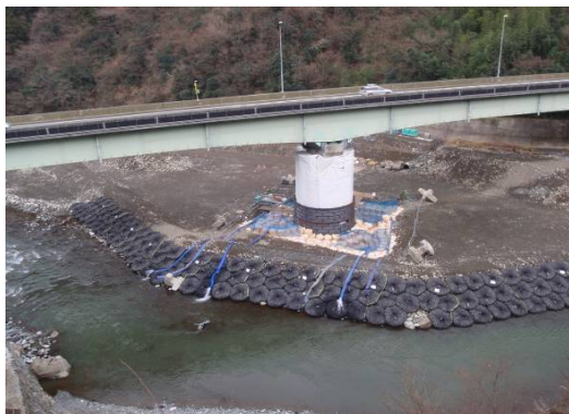
橋脚巻立て工及び瀬替え工
