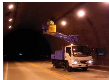
トンネル施設の点検
