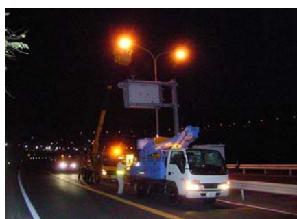
照明施設の点検・補修
