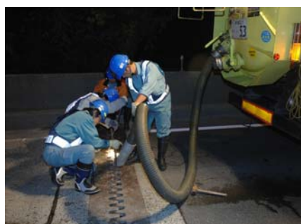
橋梁の伸縮装置清掃
