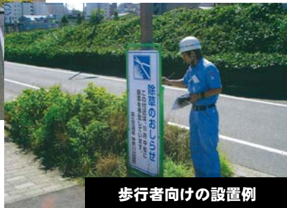
歩行者向けの設置例 (国道15号川崎市川崎区榎町付近)
