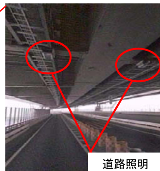
道路照明 国道357号横浜ベイブリッジ(一般部)
