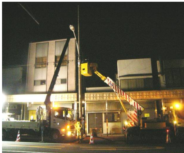
完成又は施工状況写真
