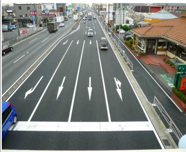
完成又は施工状況写真
