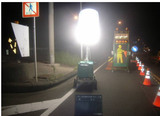
完成又は施工状況写真
