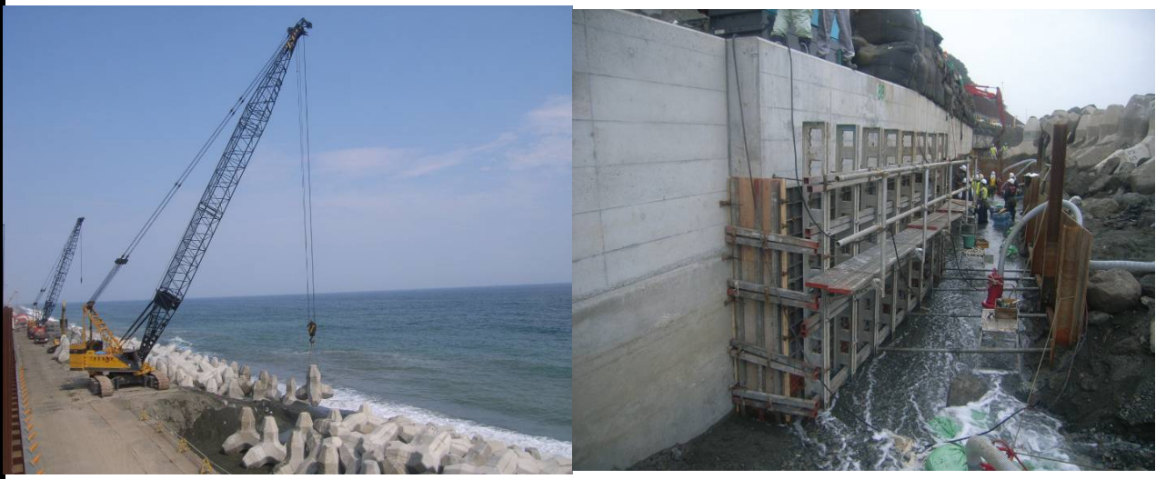
完成又は施工状況写真
