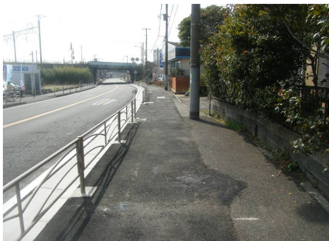
完成又は施工状況写真
