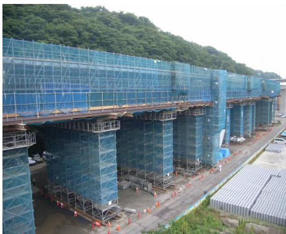
完成又は施工状況写真
