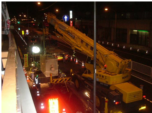
完成又は施工状況写真
