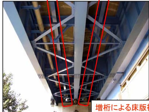
増桁による床版補強
