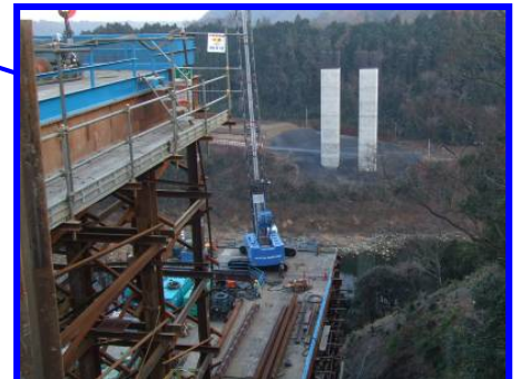
相模川橋（仮称）下部工事
