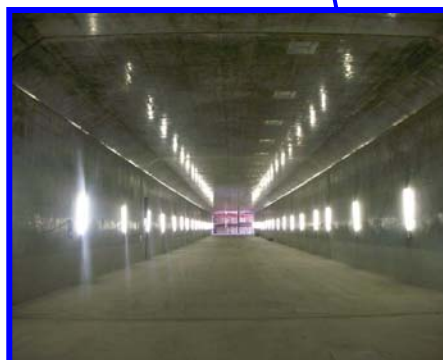
上依知第二トンネル(仮称)工事
