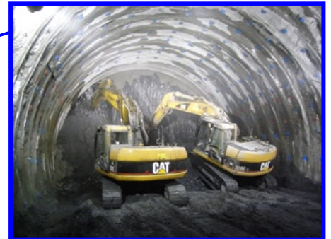
城山八王子トンネル（仮称）工事
