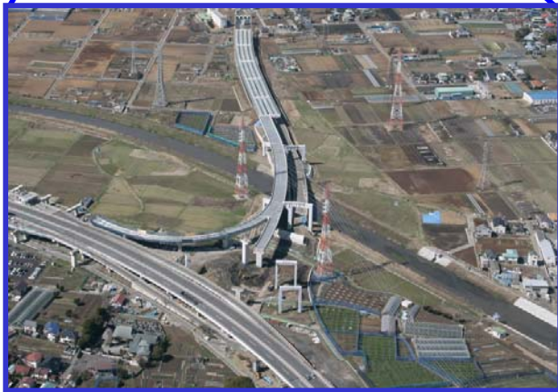
西久保JCT（仮称）付近
