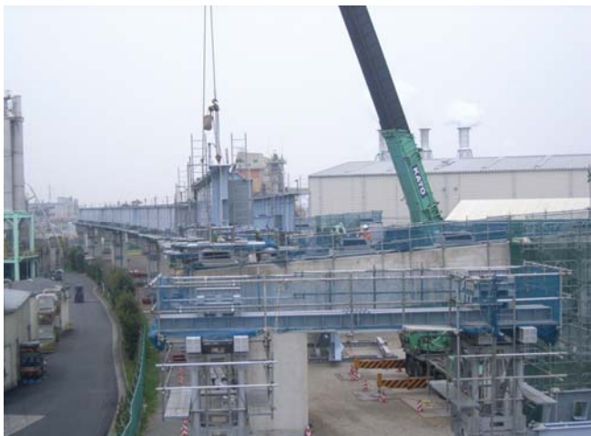
完成及び施工状況写真
