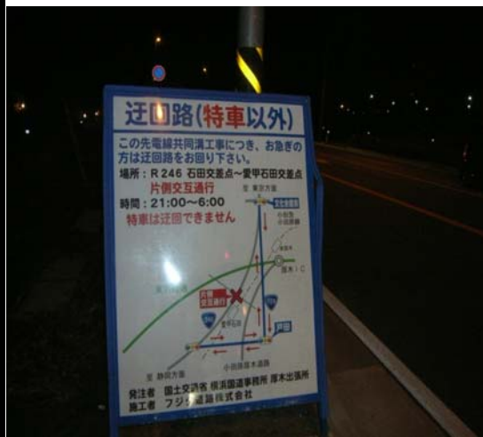
完成及び施工状況写真
