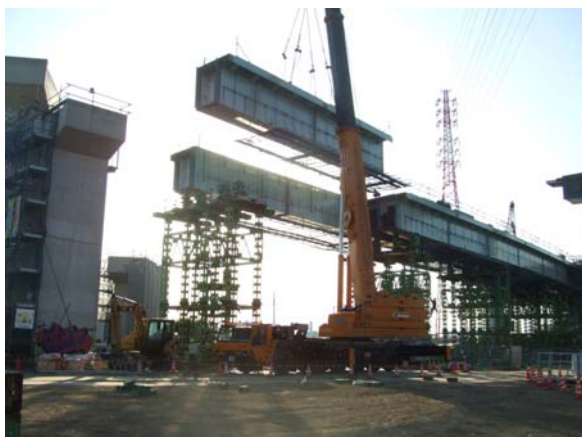
完成及び施工状況写真
