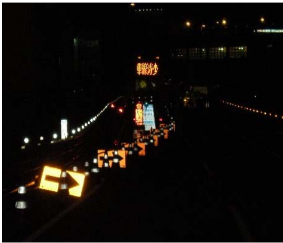
完成及び施工状況写真
