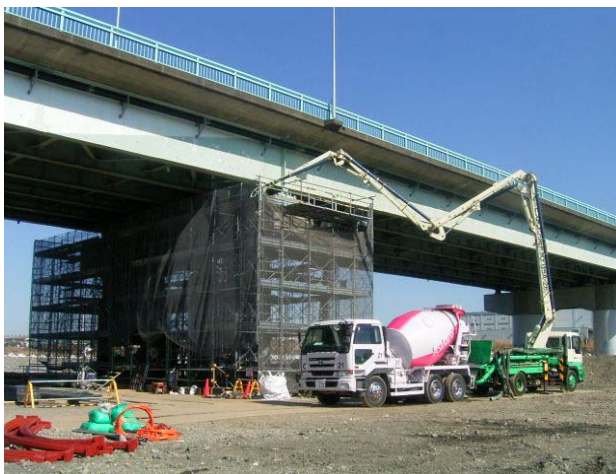
完成及び施工状況写真
