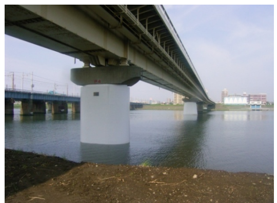
橋脚補強施工後
