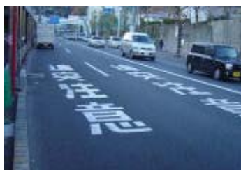
「追突注意」路面標示設置
