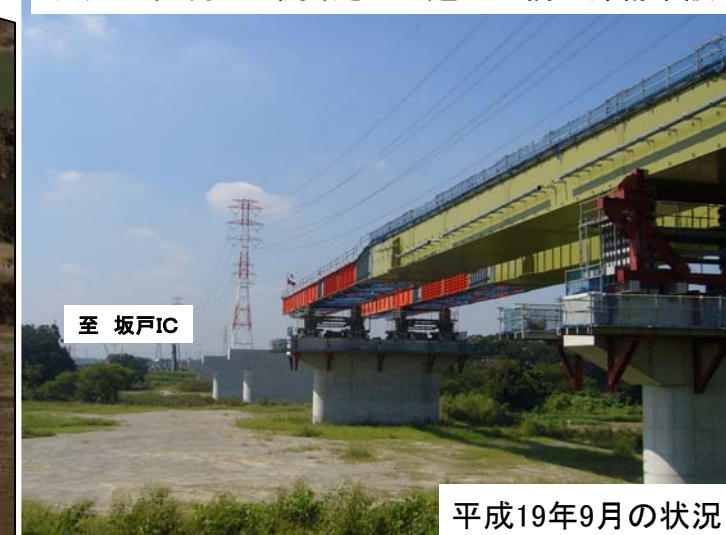
平成19年9月から開始された越辺川橋上部桁架設
