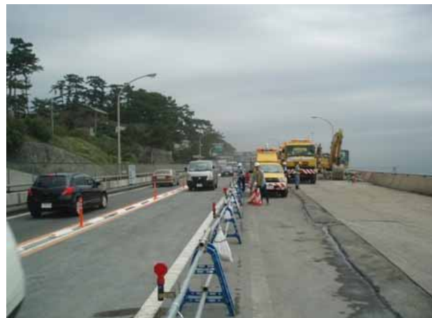
対面通行と復旧工事状況 27日11時20分撮影
