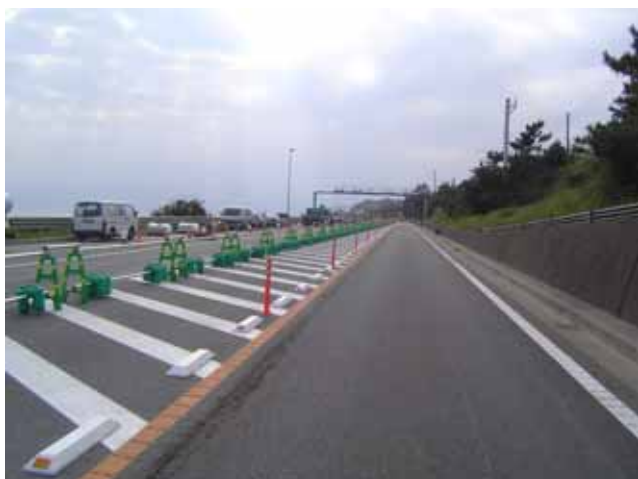
保安施設工の設置状況 26日15時撮影
