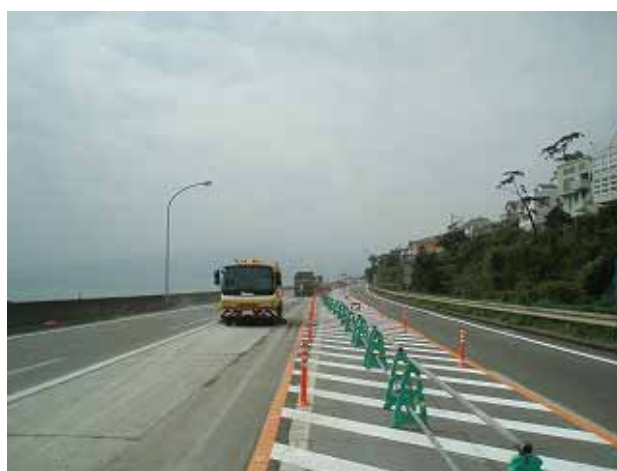
保安施設工（2車線 4車線の移行） 26日14時撮影
