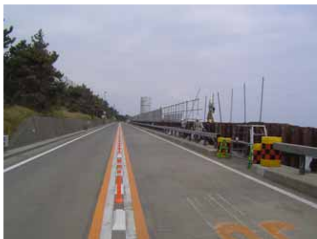
保安施設工の状況 26日13時40分撮影
