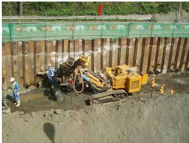
シートパイルアンカー工施工状況 25日14時撮影
