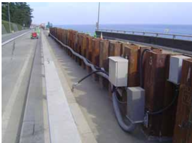
変位計測機器の設置状況 25日14時撮影
