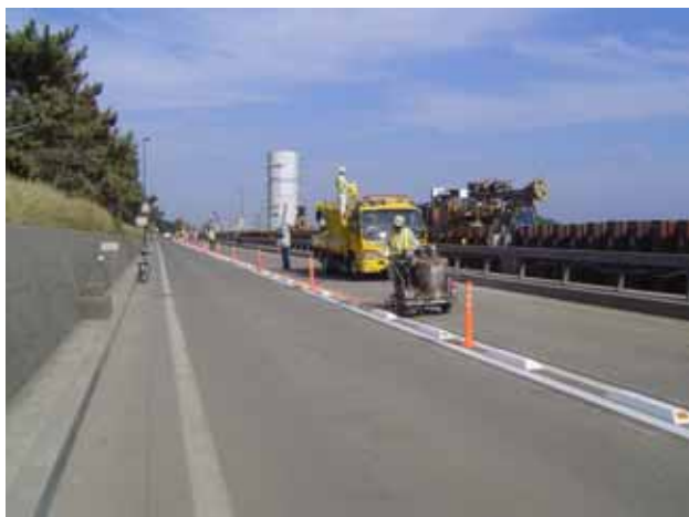
保安施設工の状況 25日14時撮影
