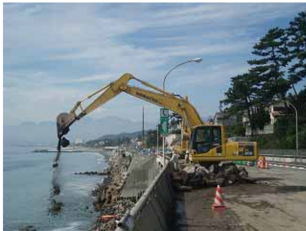
仮設消波堤の施工状況 25日14時撮影
