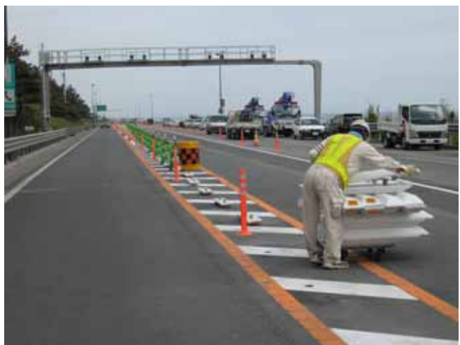
保安施設工の状況 24日14時撮影
