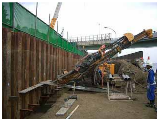
シートパイルアンカー工施工状況 24日14時撮影
