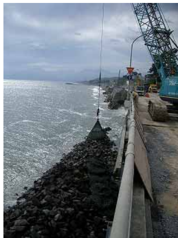
仮設消波堤の施工状況 24日14時撮影
