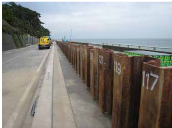
空隙充填箇所でのコンクリート打設の状況 24日14時撮影
