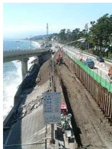
シートパイル前面整地状況 20日13時撮影
