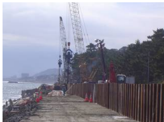
シートパイル打設状況 20日14時撮影
