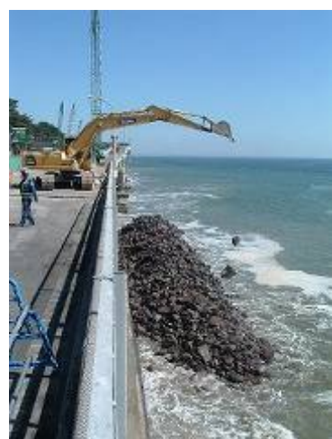
仮設消波堤築堤状況 20日13時撮影
