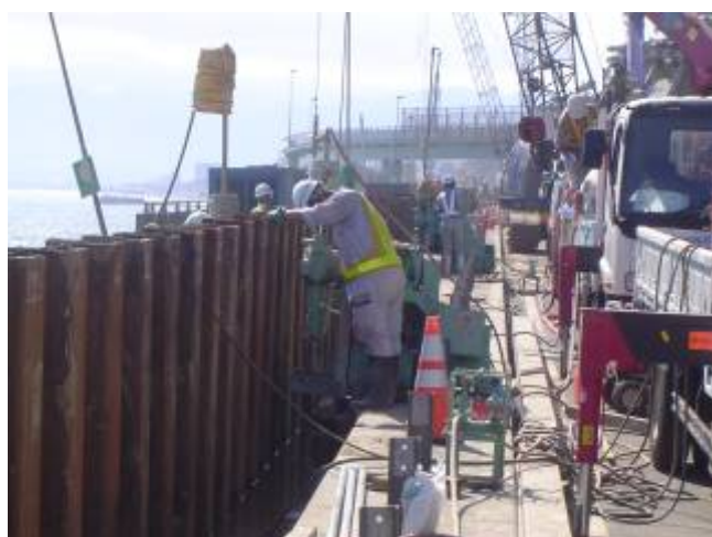
シートパイルと道路の空隙充填作業の状況 20日14時撮影
