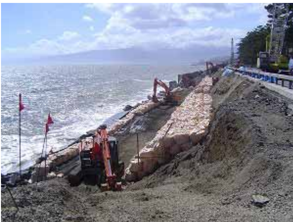
土のう設置の状況 16日13時撮影
