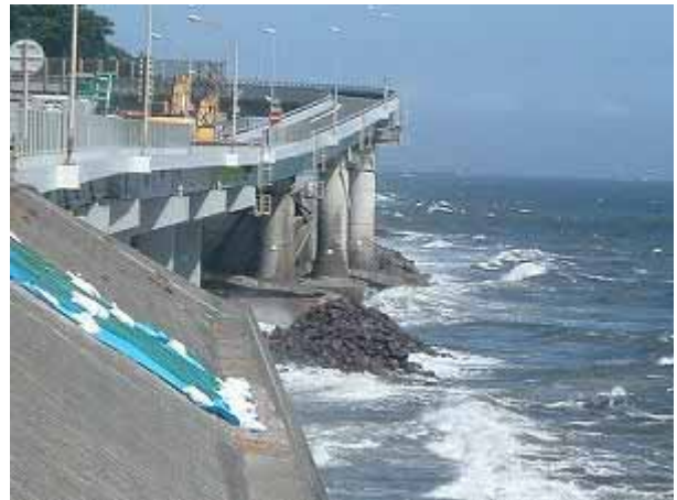
仮設消波堤築堤状況 16日13時撮影
