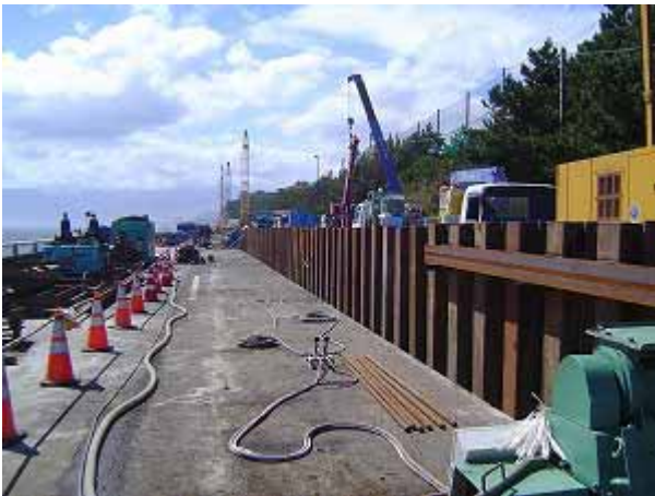
シートパイル打設済み区間の状況 16日13時撮影
