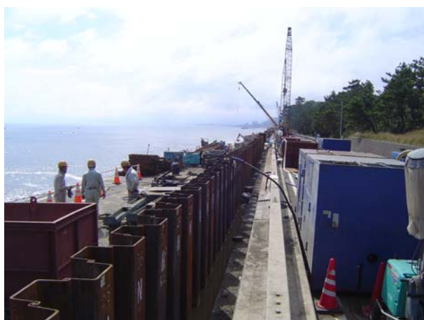
シートパイル打設済み区間の状況 15日13時撮影
