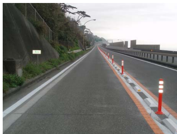
西湘二宮IC方面を望む（上り線開通前） 15日11時10分撮影
