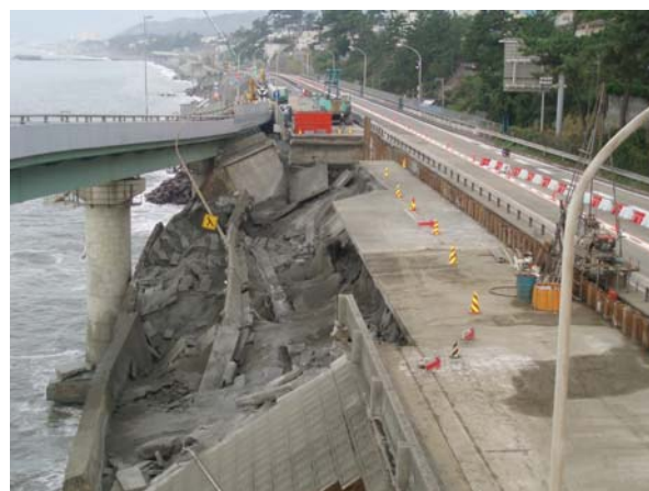
上り線応急復旧の完了（西湘二宮IC） 15日10時撮影
