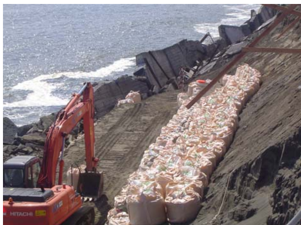
土のう設置の状況 15日13時撮影
