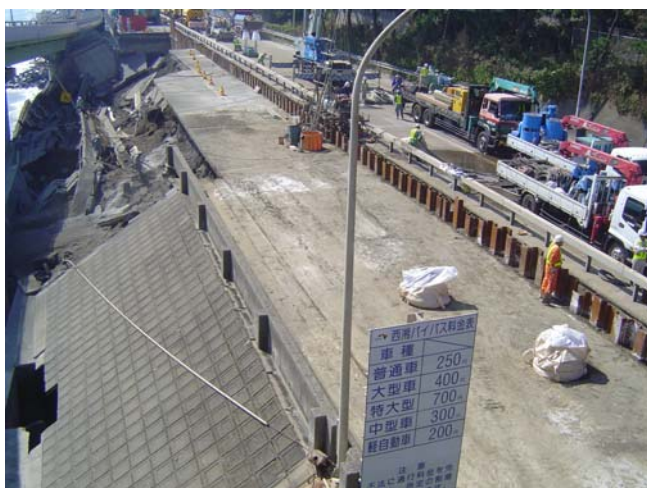
シートパイル設置の状況 14日15時分撮影
