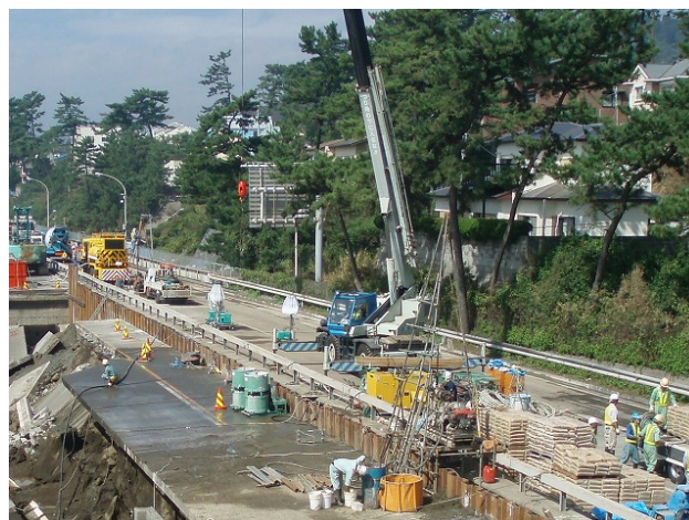
シートパイル補強工の完了 14日13時撮影
