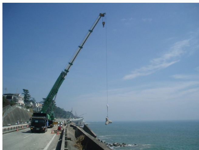
海岸部流出防止対策の状況 14日13時撮影
