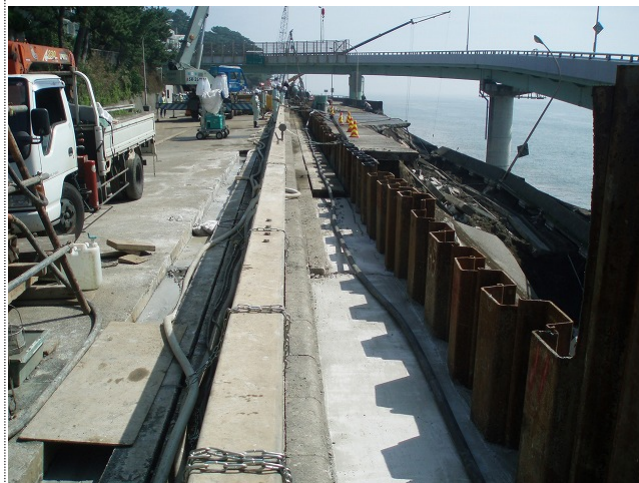
シートパイル補強工の完了 (近景) 14日13時撮影
