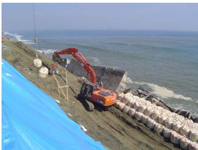
土のう設置の状況 14日15時撮影
