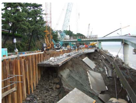
シートパイル打設の状況 12日13時撮影
