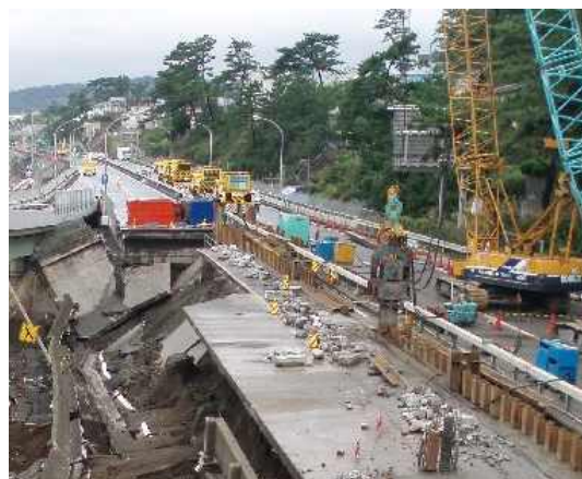
西湘二宮ICから国府津IC方面を望む 12日13時撮影
