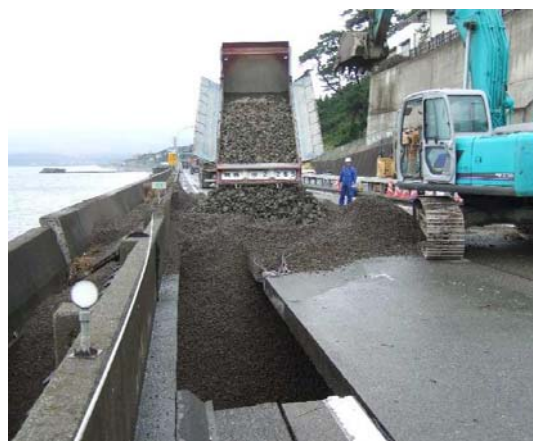
侵食された部分の埋め戻し状況 12日13時撮影
