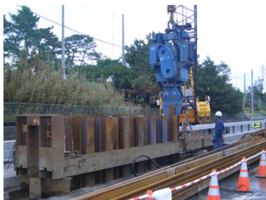
シートパイル打設の状況 12日14時30分撮影
