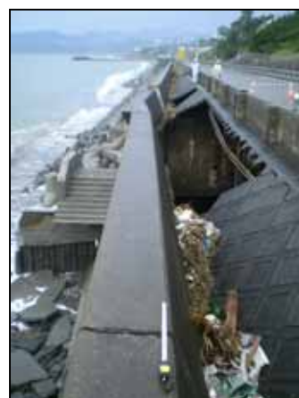
本線被災箇所の調査状況 11日12時撮影
