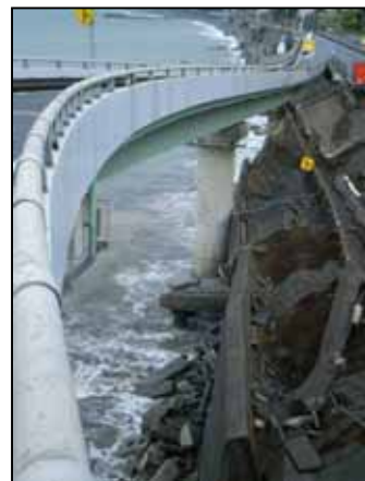
西湘二宮IC付近の擁壁破損、路面崩壊 11日12時撮影
