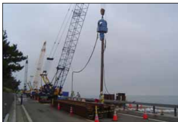
シートパイル打設の状況 11日15時30分撮影
