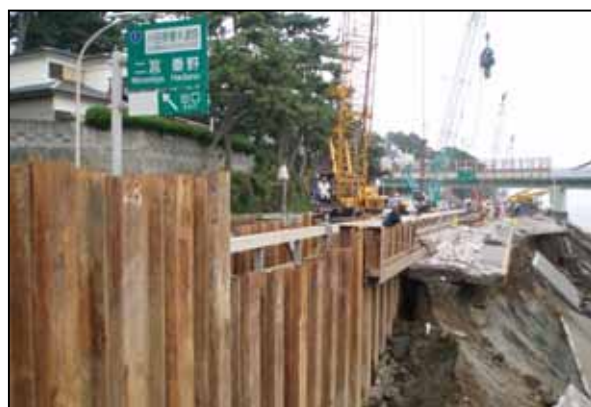
西湘二宮IC付近シートパイル設置工の状況 11日12時撮影
