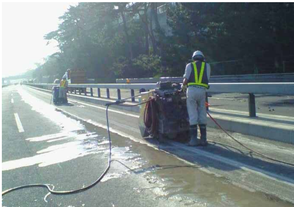
アスファルト舗装版の切断状況 ( 1 6 時 0 0 分撮影 )
