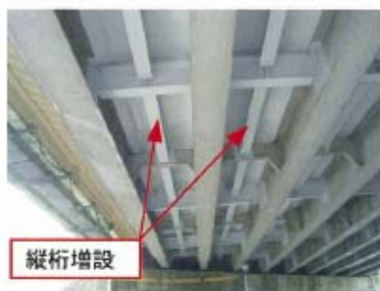
国道246号つつじ橋
