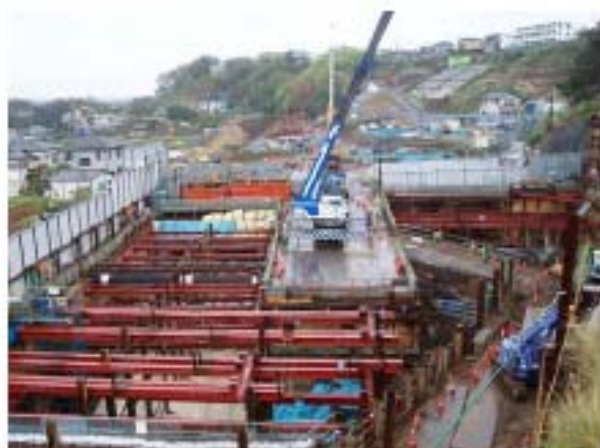
さがみ縦貫道路(上依知第二トンネル) ③
