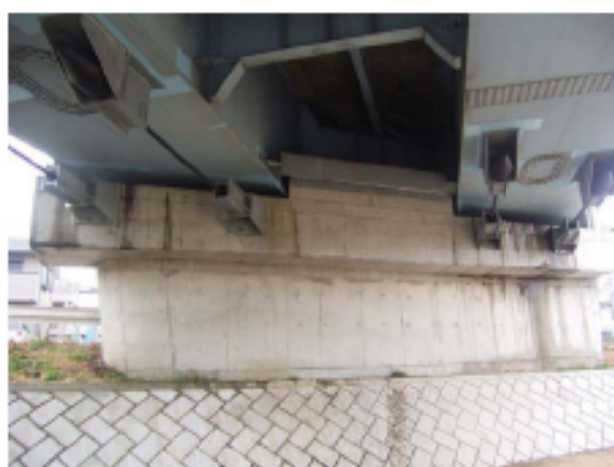
耐震補強対策の事例(巻立コンクリート)
