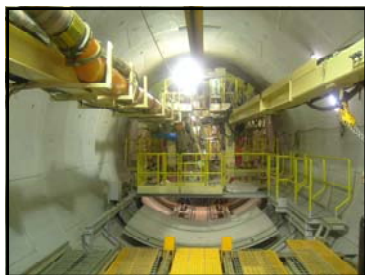
トンネル掘削の 最先端部にある 直径約 6 mの ハマシールド636
