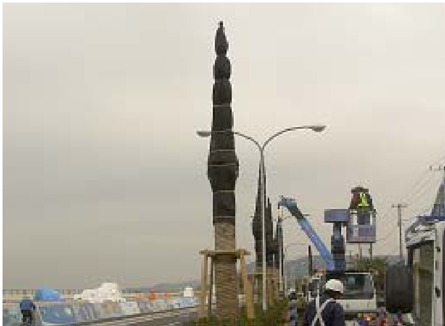
H17年に植栽したカナリーヤシの冬支度状況
