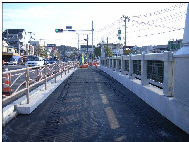
今後舗装を行う 横浜方面行き
