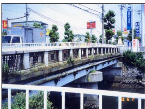
平成元年の内川橋
