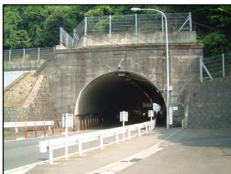
新船越トンネル
