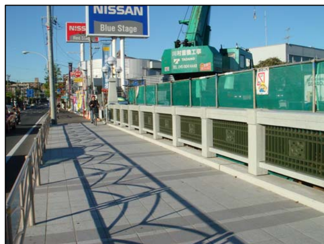
歩道が完成した 横須賀方面行き
