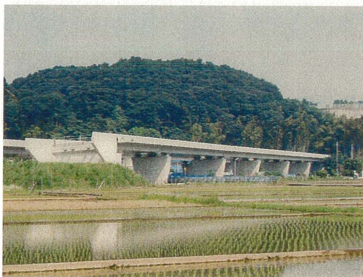
上依知高架橋
