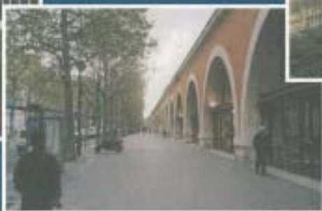
再生された高架構造物
